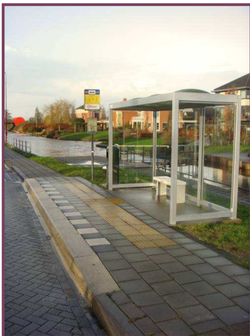
Afbeelding 8.3; Toegankelijke halte aan de Nanningaweg
